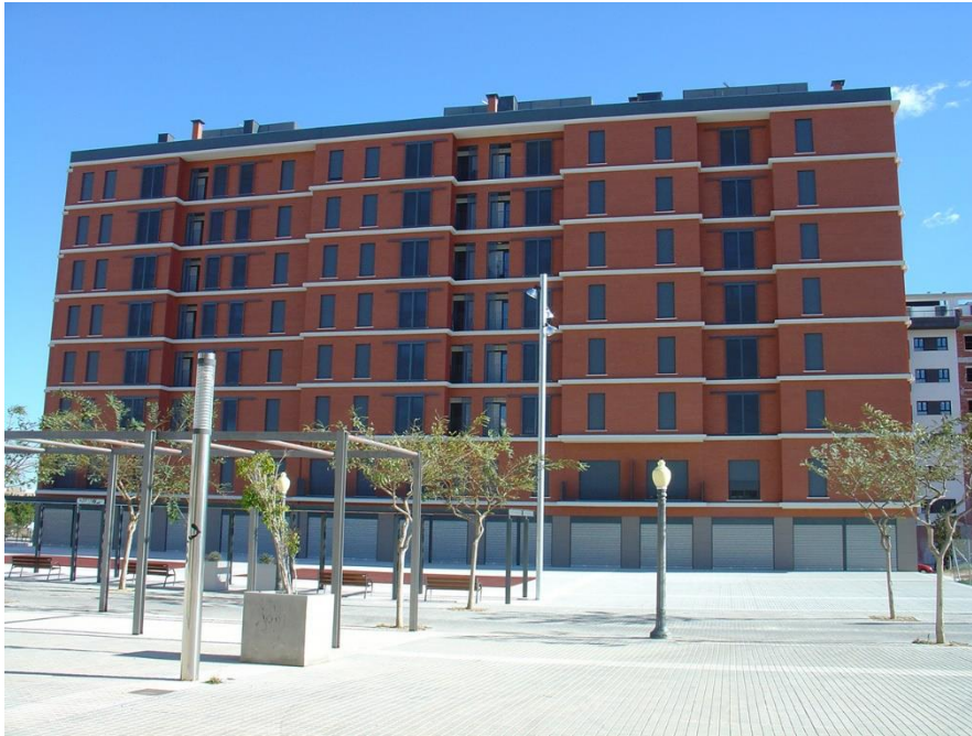
Edificio La Magrana de viviendas protegidas promovidas por PIMESA
